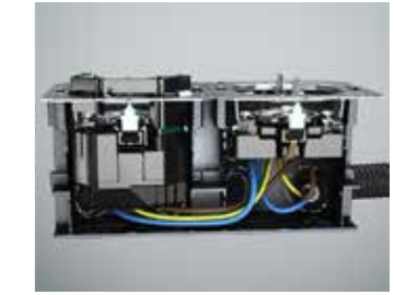
...ohne die Leiter in Bögen von einer zur anderen Dose zu legen.
