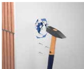
Öffnen der Dosen mit einem Hammerschlag.
