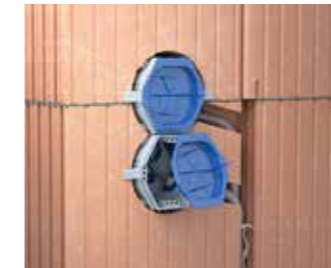
Signaldeckel (Art.-Nr. 1181-65) aufsetzen.
