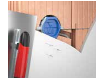
Beim Verputzen legen sich die weichen Signalborsten um ohne zu spritzen und zeigen später die Position der Dose an.
