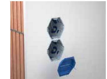
...sind die Dosen sauber geöffnet, der Signaldeckel kann mehrmals verwendet werden.
