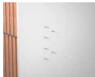
Die Signalborsten zeigen nach dem Verputzen die Position der Dosen an.
